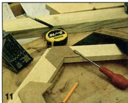
Вершина стропильной конструкции соединена фанерными накладками.
