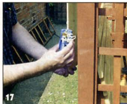
Последнюю доску обшивки подгоняют торцевым рубанком по ширине.
