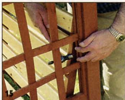
Решётку из тонких планок вставляют в верхние проёмы боковых стенок.
