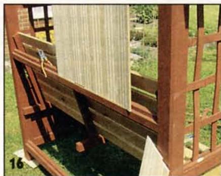
Заднюю стенку тоже обшивают вагонкой.
