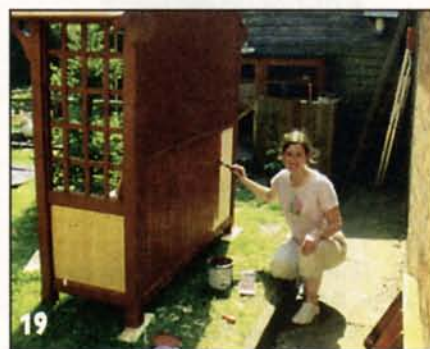
Заднюю стенку спереди и сзади красят по-разному.
