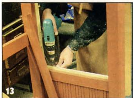
Планки сечением 12x12 мм прибивают к перемычкам боковых стенок, формируя фальц.
