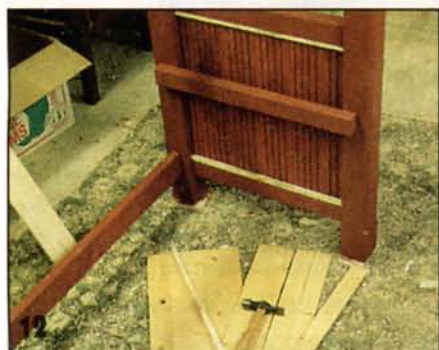
Обшивку из шпунтованных досок удерживают планки, прибитые к перемычкам.
